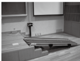
スロープ設置 車いすでの壇上へのアクセスが可能となる
