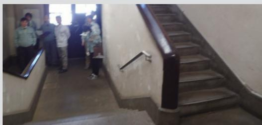
構内には、屋外から数段の階段を上った場所に玄関ホールがあり、玄関ホールに入るとまた数段の階段を上げて1階レベルにアプローチする建物がある。車イス利用者のアクセスのためスロープを設置しようとする、①外部のスロープが長く歩道と干渉する、②内部のスペースが狭く法定勾配以下のスロープを設置できないなどのため、対応が難しいことが多い。
