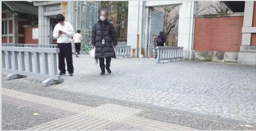
門の前の歩道部分と門内にも誘導用ブロックが敷設されているが、門周囲には敷設されていないため、誘導が絶たれている。
