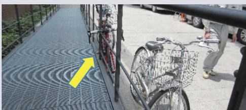
スロープ支柱に立てかけて駐輪するため、ハンドルがスロープに飛び出してスロープ幅を狭めており、車イスで通行しにくい。
