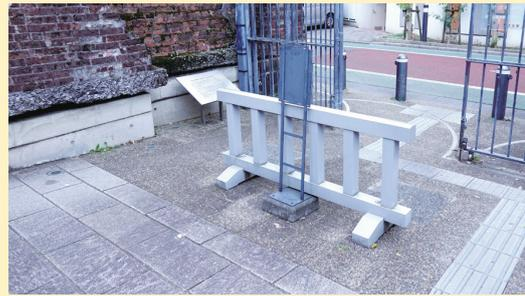
**改善例** ポールとチェーンを撤去し、腰程度までの高さの木製車止めを設置。照明を明るく変えて、視認しやすくした。
