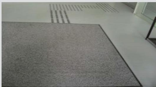
誘導用ブロック上にマットが置かれ、誘導が遮断され、進行方向がわからなくなる。
