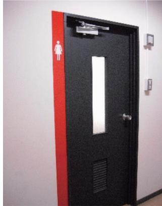
**工夫例** 廊下と壁の境界部にコントラストの強い色のボーダーを入れてエッジを強調して空間の形状を分かりやすくする。
