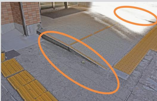
段差解消のためのスロープが新たな段差を生じさせており、つまづく危険がある。
