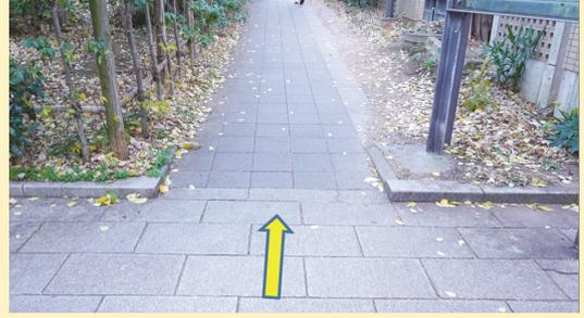
**改善例** 区道を管轄する自治体に交渉し、車イスの幅分の段差解消工事を実施した。
