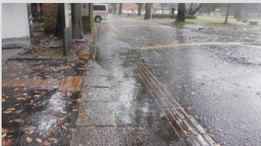
降雨後、水溜まりに水没し、誘導情報が断絶し、進行方向を見失う。
