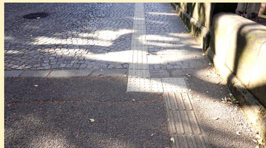
**改善例** 構内全ての路面を平滑にするのは現実的ではないので、よく使う経路、あるいは負担の大きな坂道の一部を車イスがすれ違うことができるように 200cm 幅の目地を整えて石の表面を削り平滑化。
