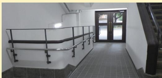
**改善例** 玄関ホールの床を30cmほどかさ上げして、建物内部に建物1階までの法定勾配以下のスロープを設置、外部は空間に余裕があるため、建物の外壁に沿って法定勾配以下のスロープを設置し、車イスで無理なく利用できる出入口にしている。
