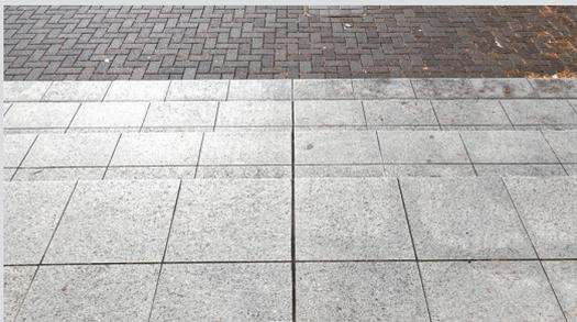
段鼻が見えにくく、階段の始点も、段数も識別しにくいため、弱視者には階段の存在を視認し難く、踏み外す危険がある。
