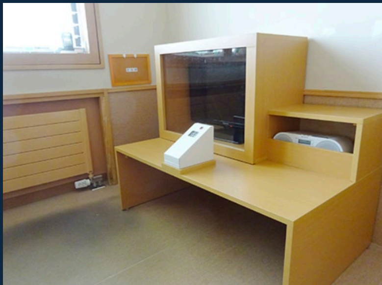
図21 混乱による破壊行為予防のための テレビガードを設置した居室
